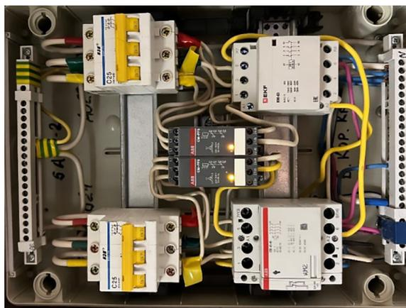
Рис. 1. Электро-механическое АВР на двух реле и двух контакторах
